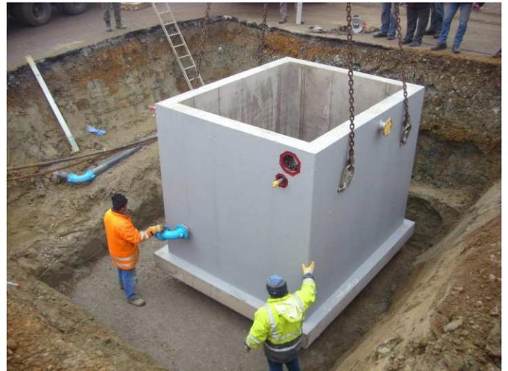
Foto: Einbau der Drucksteigerungsanlage für die Ortswasserleitung Unterrödham und „Mayböck-Siedlung“
